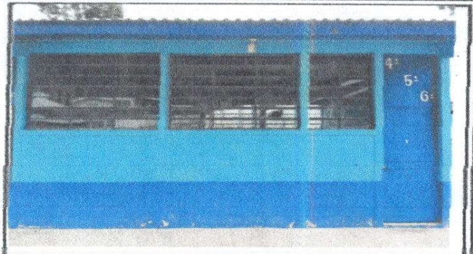
Foto 2: Sustitución de halcones de metal
