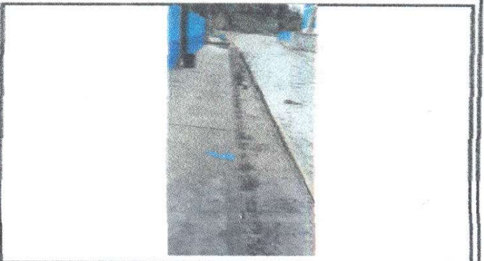
Foto 4: Reparación de panchas de concreto de patio
