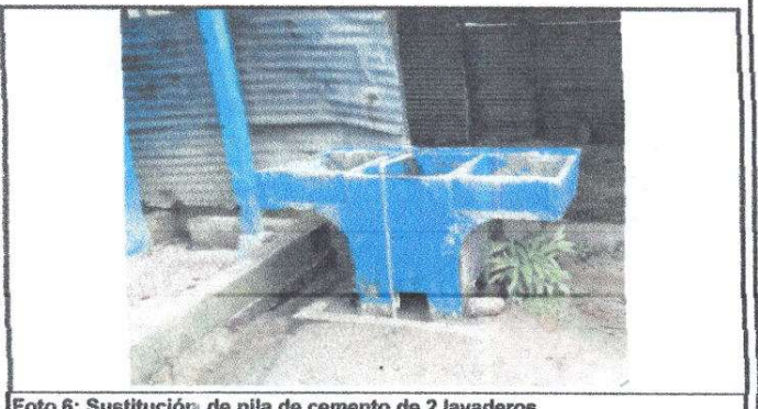
Foto 6: Sustitución de pila de cemento de 2 lavaderos
